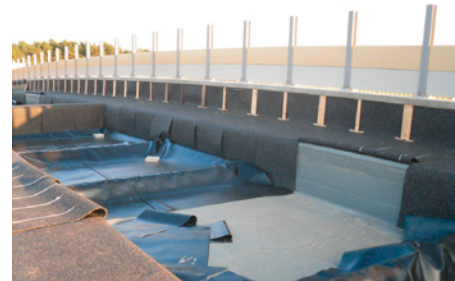
Abdichtung der Wasserspeicher
