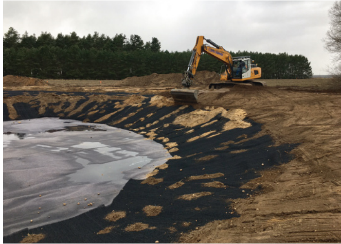
Abdichtung des neuen Amphibienlaichgewässers „Karpfenkuhle“
