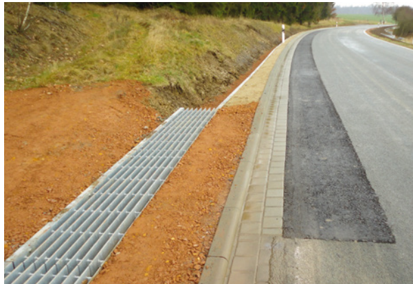
Oben: Leiteinrichtung und Straßendurchlass im Bereich des Amphibienlaichgewässers
