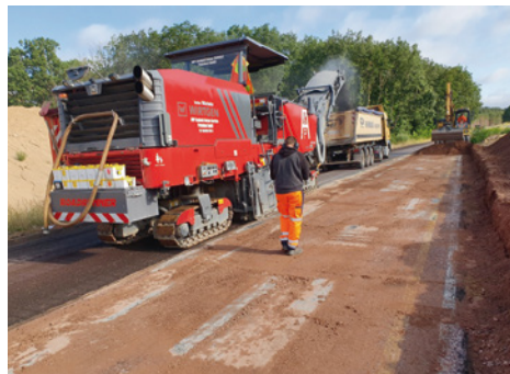
Eine Asphaltfräse entfernt die wiederverwendbaren Schichten der Straßendecke
