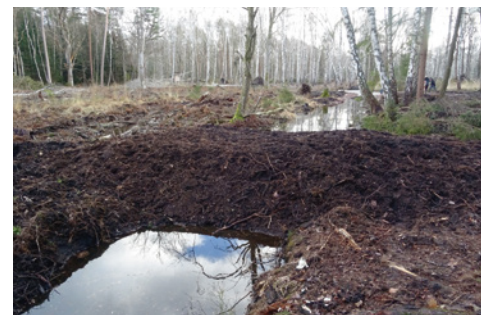
Die bisher Wasser abführenden Gräben wurden an zahlreichen Stellen verfüllt oder durch Querdämme unterbrochen („gekammert“). Das Material dafür (Torf und Holz) stammt direkt aus dem Gebiet.
