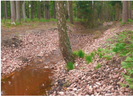
Einbau von Sohlgleiten in das Grabensystem
